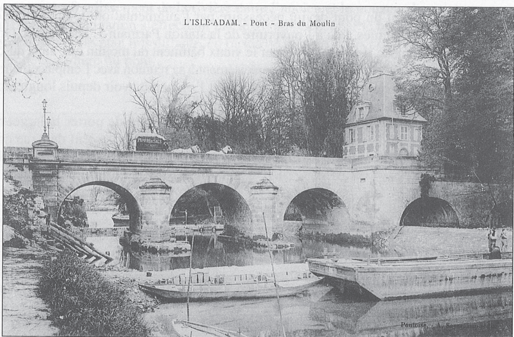
Le pont, vu d'amont et vu d'aval.
