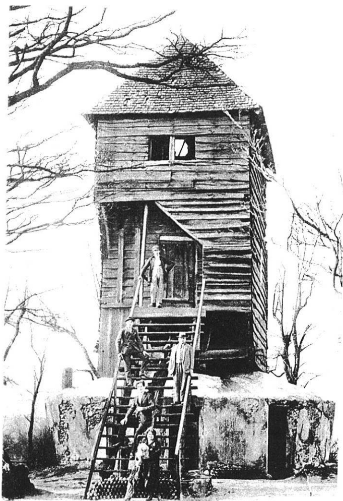
Photo Désiré, à Sannois (Seine-et-Oise) Les Vieux Moulins de SANNOIS (S.-et-O.), datant de 1625.
