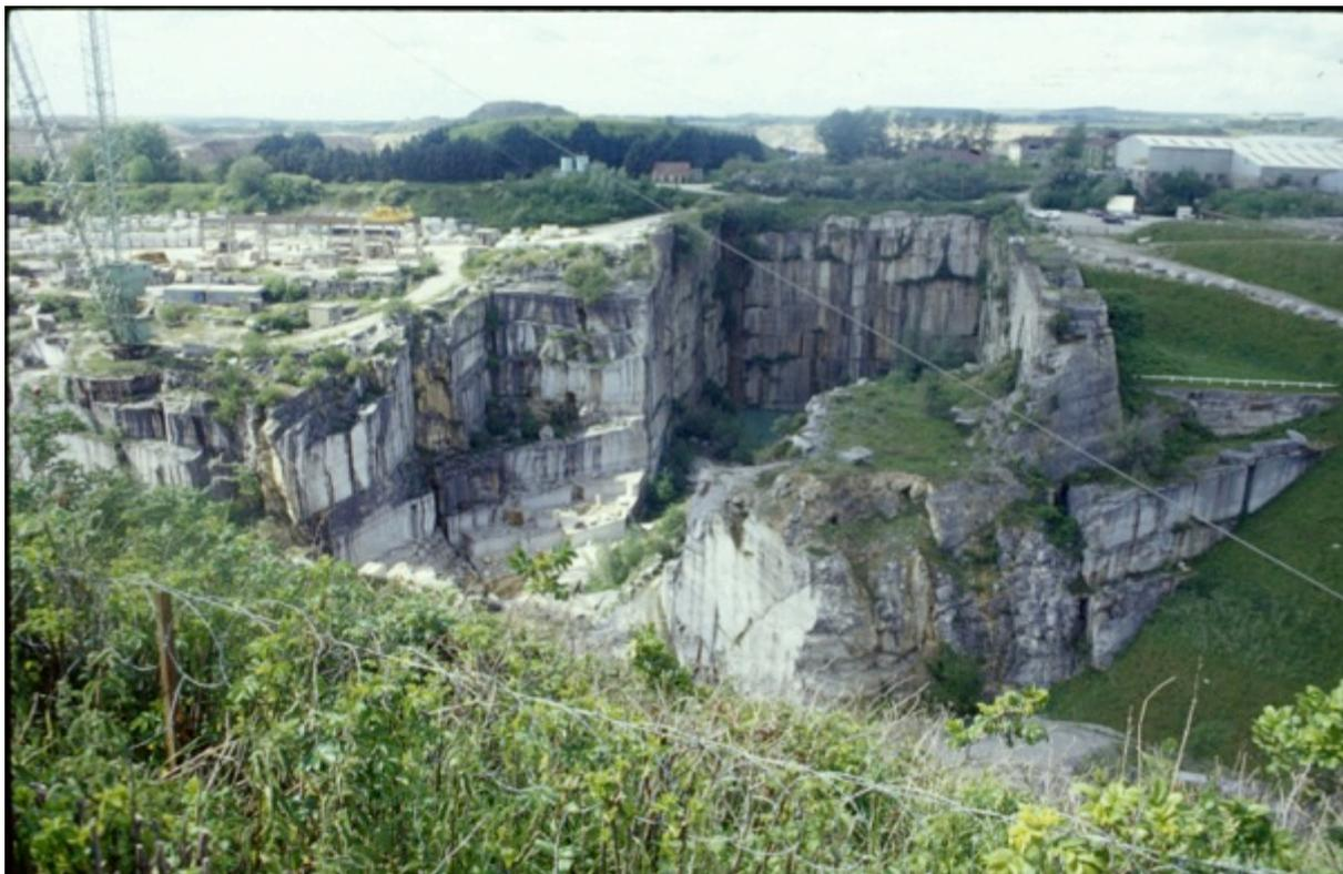
Compte tenu de la dureté du calcaire, il faut recourir à la dynamite pour abattre les pans de roche
