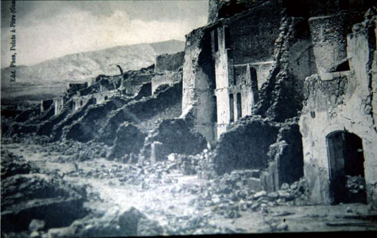
Ce qui restait de la rue du Figuier
