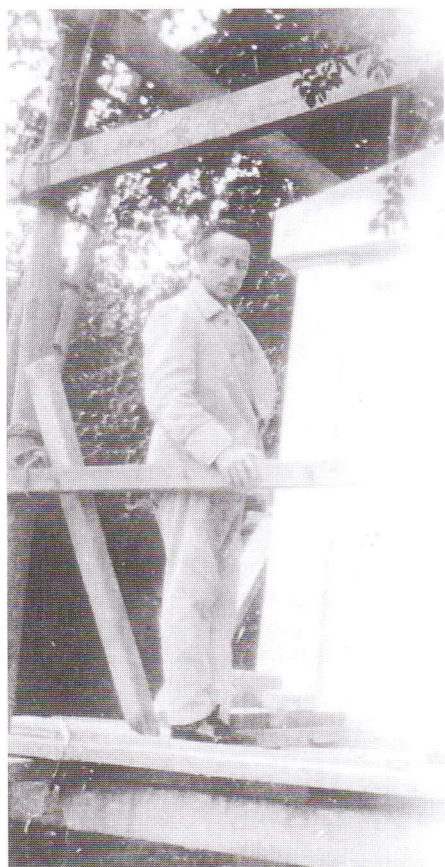
Charles Geoffroy-Dechaume sur l'échafaudage du Monument aux morts dit «du cimetière».
