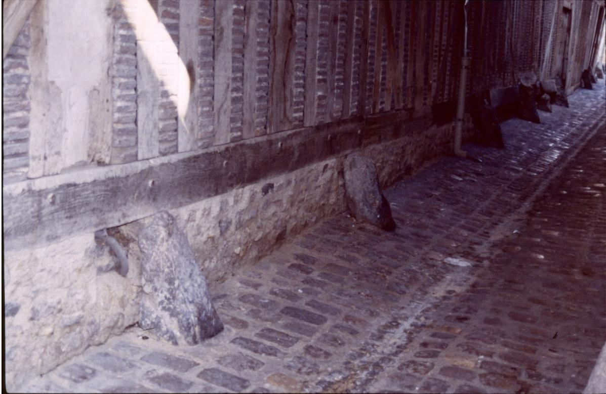
Puis, on bouchait les interstices entre les poutres et les planches par des morceaux de bois ou de briques et on recouvrait le tout d'un torchis
